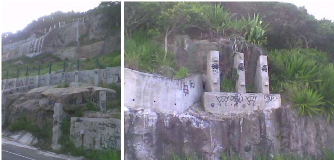
Figura 4.51 Obras de contenção de encostas nas unidades de conservação em áreas de cortes associadas à ocorrência de altas declividades. Fonte: Detzel Consulting, 2012.
