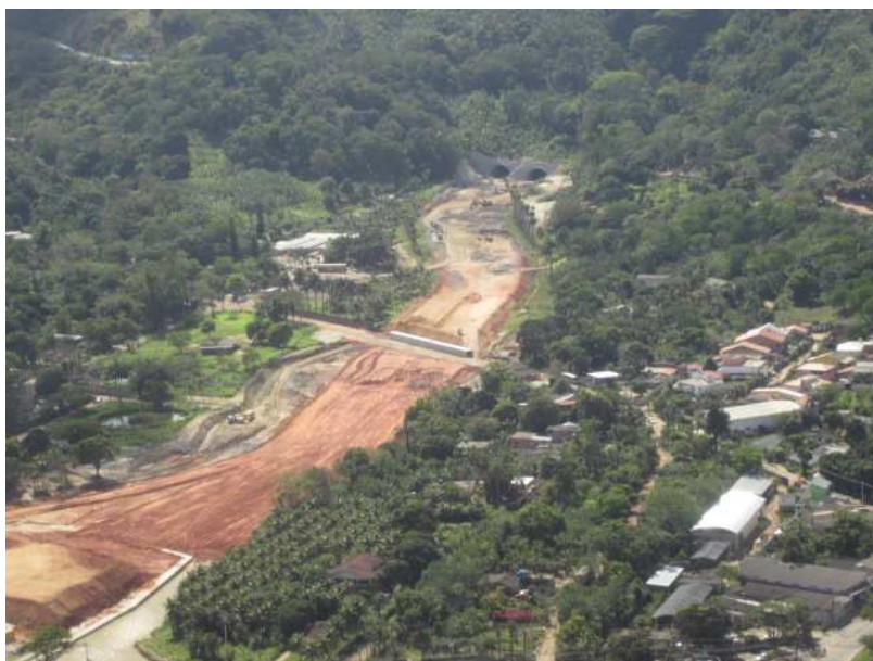
Figura 4.160 Vista das obras de abertura do Túnel Transoeste – Avenida das Américas. Fonte: Detzel Consulting, 2011.
