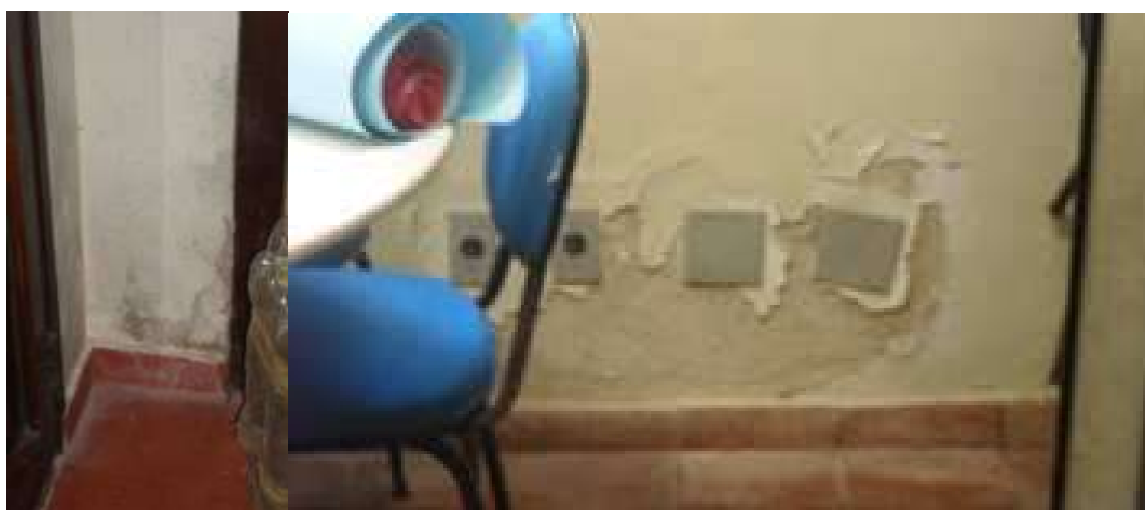
Figura 4.181 Detalhe das infiltrações nas paredes da edificação do Centro de Visitantes do PNM da Prainha. Fonte: Detzel Consulting, 2012.
