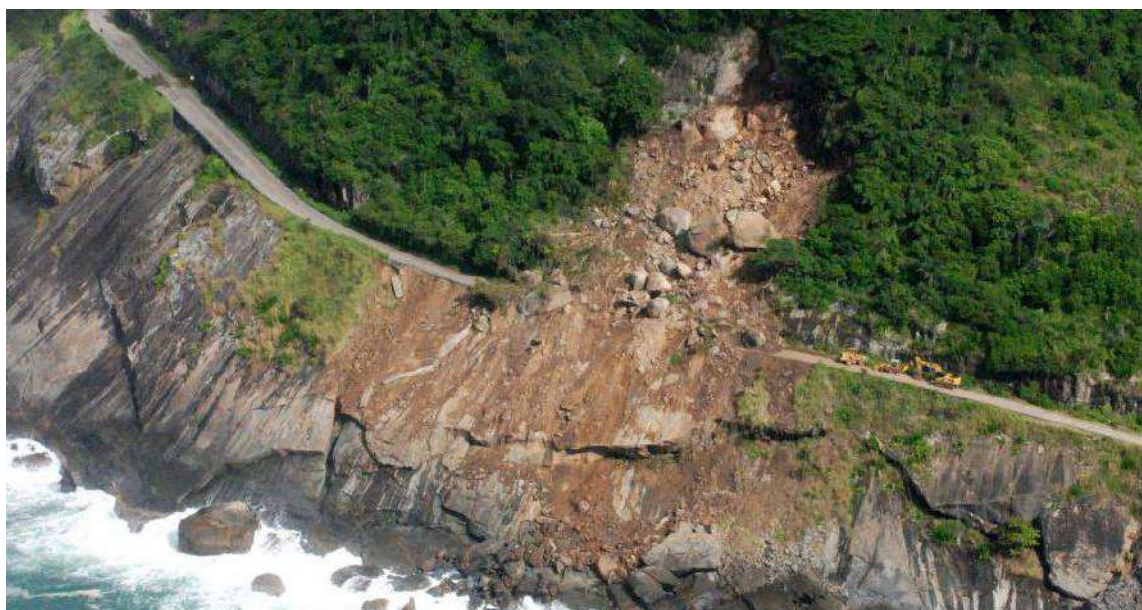
Figura 4.41 Deslizamento ocorrido na estrada entre o PNM da Prainha e o PNM de Grumari em abril de 2010. Fonte: http://noticias.uol.com.br/album/100412_album.jhtm#fotoNav=27
