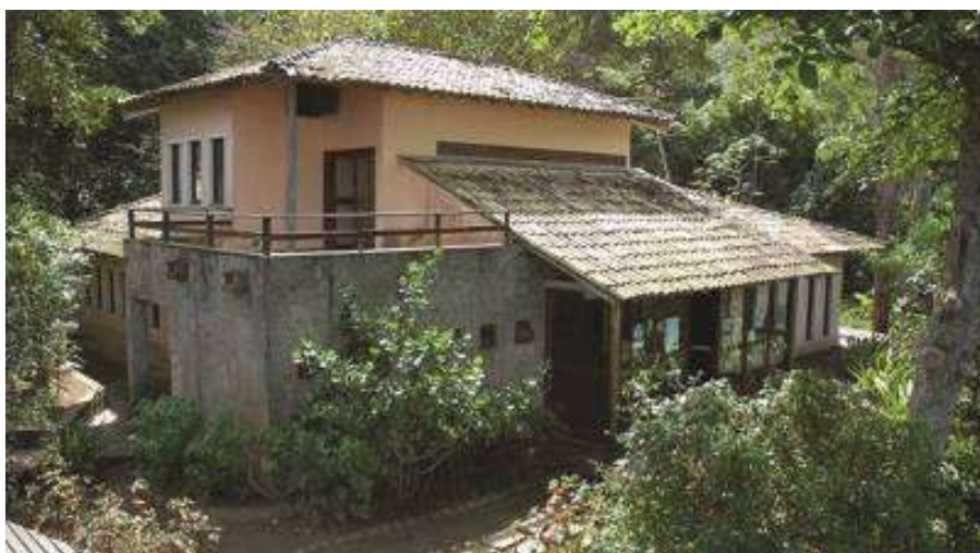
Figura 4.178 Centro de Visitantes do PNM da Prainha. Fonte: Detzel Consulting, 2012.
