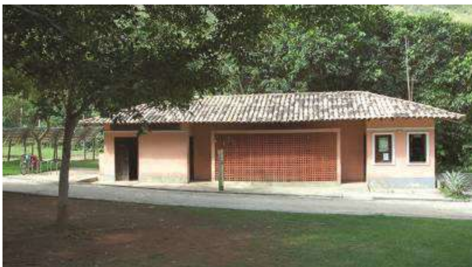
Figura 4.188 Fachada do prédio de manutenção e segurança do PNM da Prainha. Fonte: Detzel Consulting, 2012.
