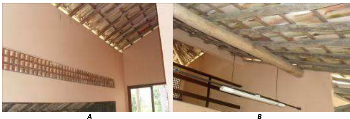
Figura 4.182 Detalhe dos elementos vazados (A) e telha aparente (B) na edificação do Centro de Visitantes do PNM da Prainha. Fonte: Detzel Consulting, 2012.
