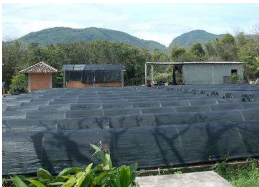
Figura 4.227 Edificações de apoio do PNM de Grumari ao fundo. Fonte: Detzel Consulting, 2012.
