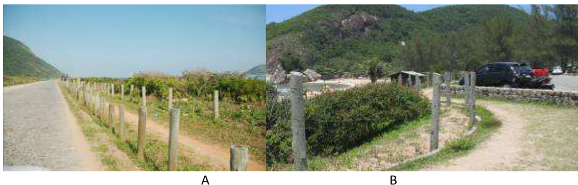
Figura 4.240 Delimitações em toras de eucalipto na via principal do PNM de Grumari. Fonte: Detzel Consulting, 2012.
