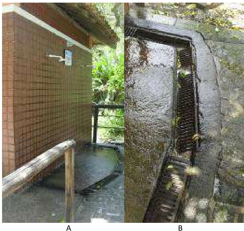
Figura 4.194 Detalhes da ducha (A) e da canaleta para escoamento da água da ducha (B). Fonte: Detzel Consulting, 2012.
