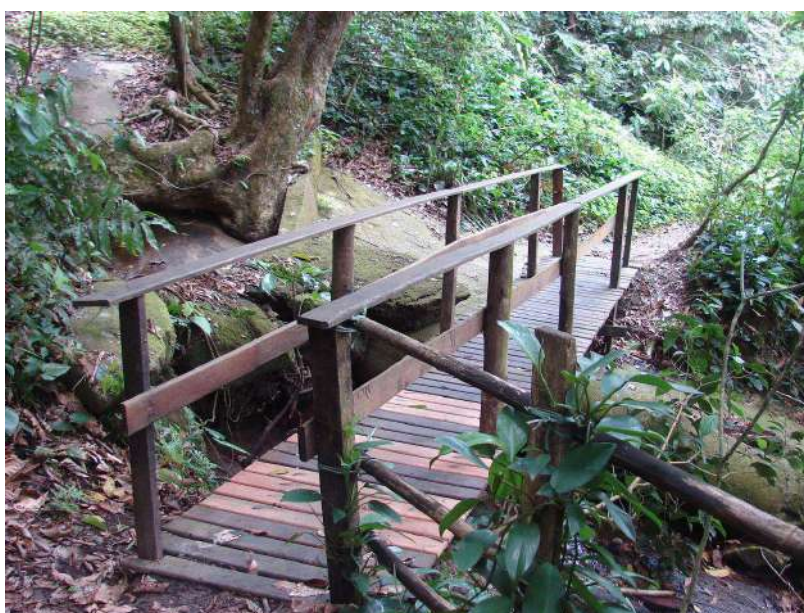
Figura 4.97 Visualização da ponte existente no trajeto da trilha Circular localizada no PNM da Prainha. Fonte: Detzel Consulting, 2011.
